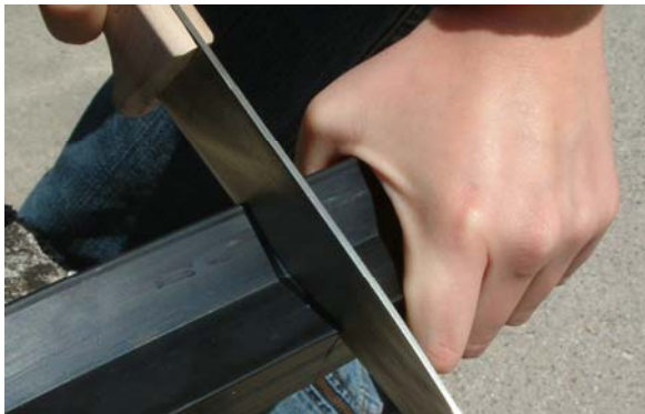
Ablängen eines Seilbahneinlageprofils
